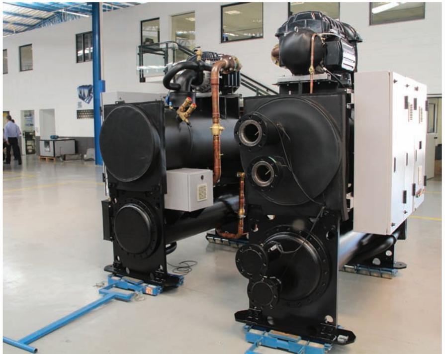
*Novo Chiller TurboTosi de condensação a água: inovação para obras sustentáveis*
